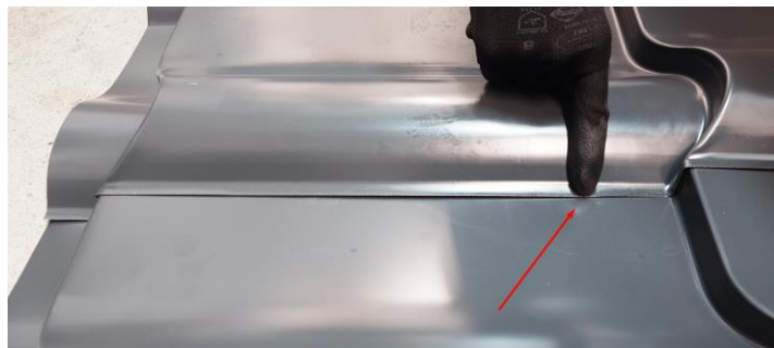
саморез со смещением от ступеньки
